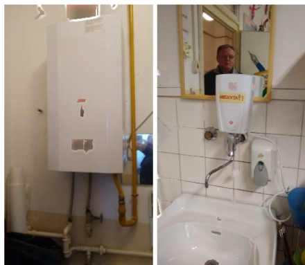
Obr. 9: Ohrev TV v budove ZUŠ
