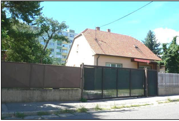
rodinný dom s.č.8468-Železničná ul.č.66
