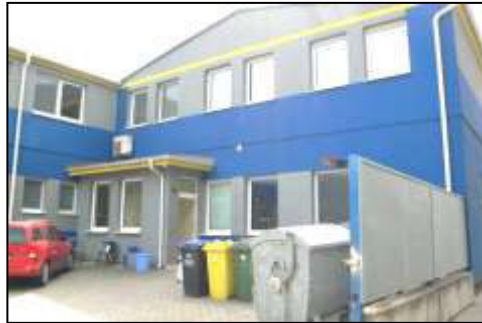
vjazd do dvora+vstup do ubytovne-SZ strana
