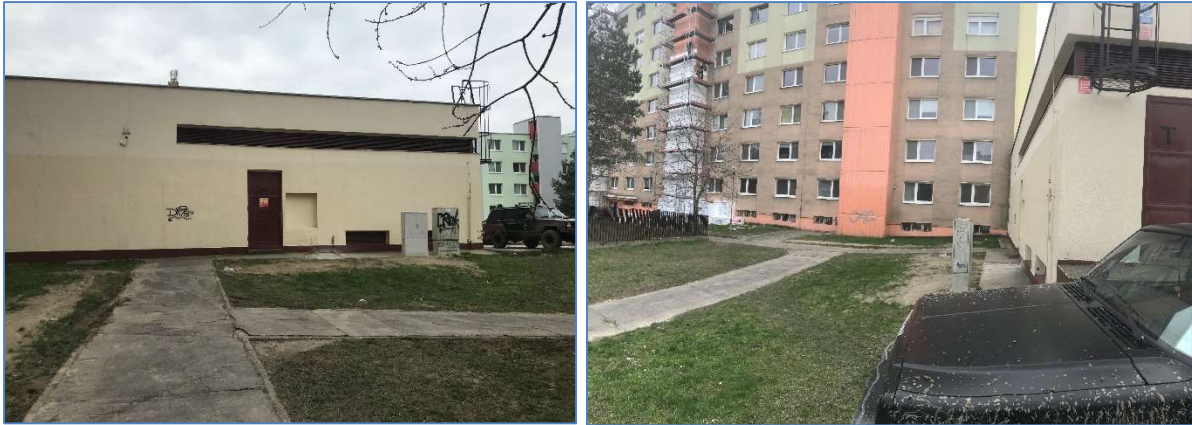
Napojenie na trafostanicu – Repaškého ul.
