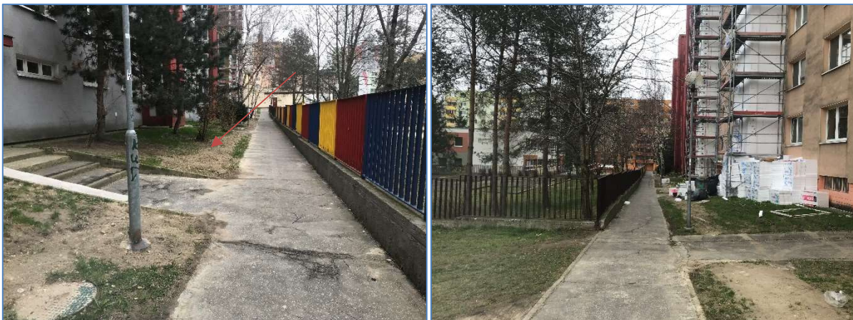
Trasa IS na ul. Repaškého – zásyp v sídliskovej zeleni
