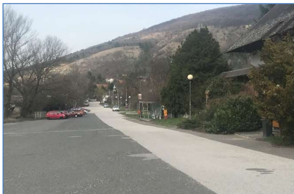
Pozemok p.č. 958/25, 27 – súčasť prístupovej komunikácie na ul. Muránska na parkovisko, po pravej strane. Hranice v teréne neznáme, vedenie osvetlenia.
