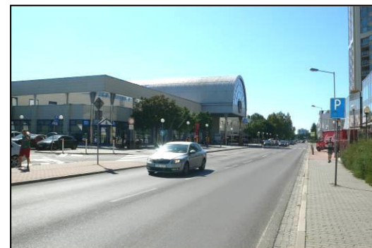
naľavo-budova železničnej stanice
