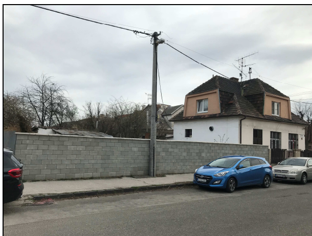
Oplotenie pozemku z ul. Pri strelnici
