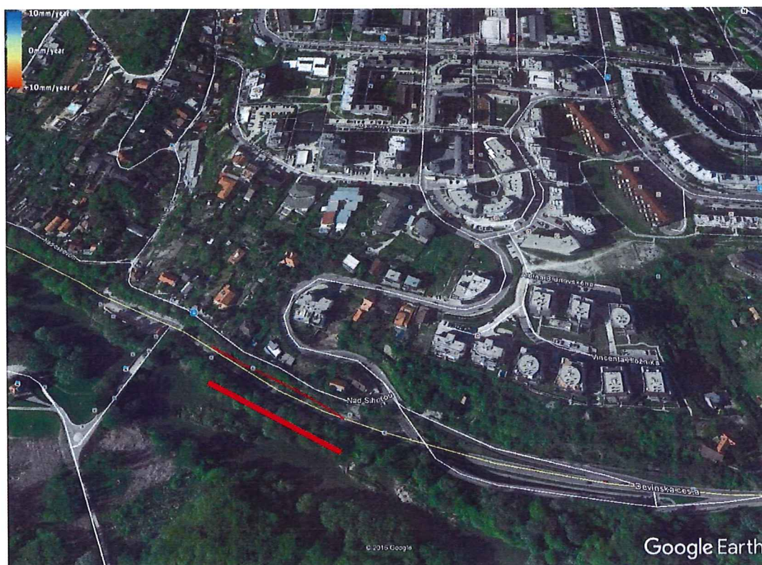
Obr.1 Lokalizácia skalného zrútenia na Google Earth
