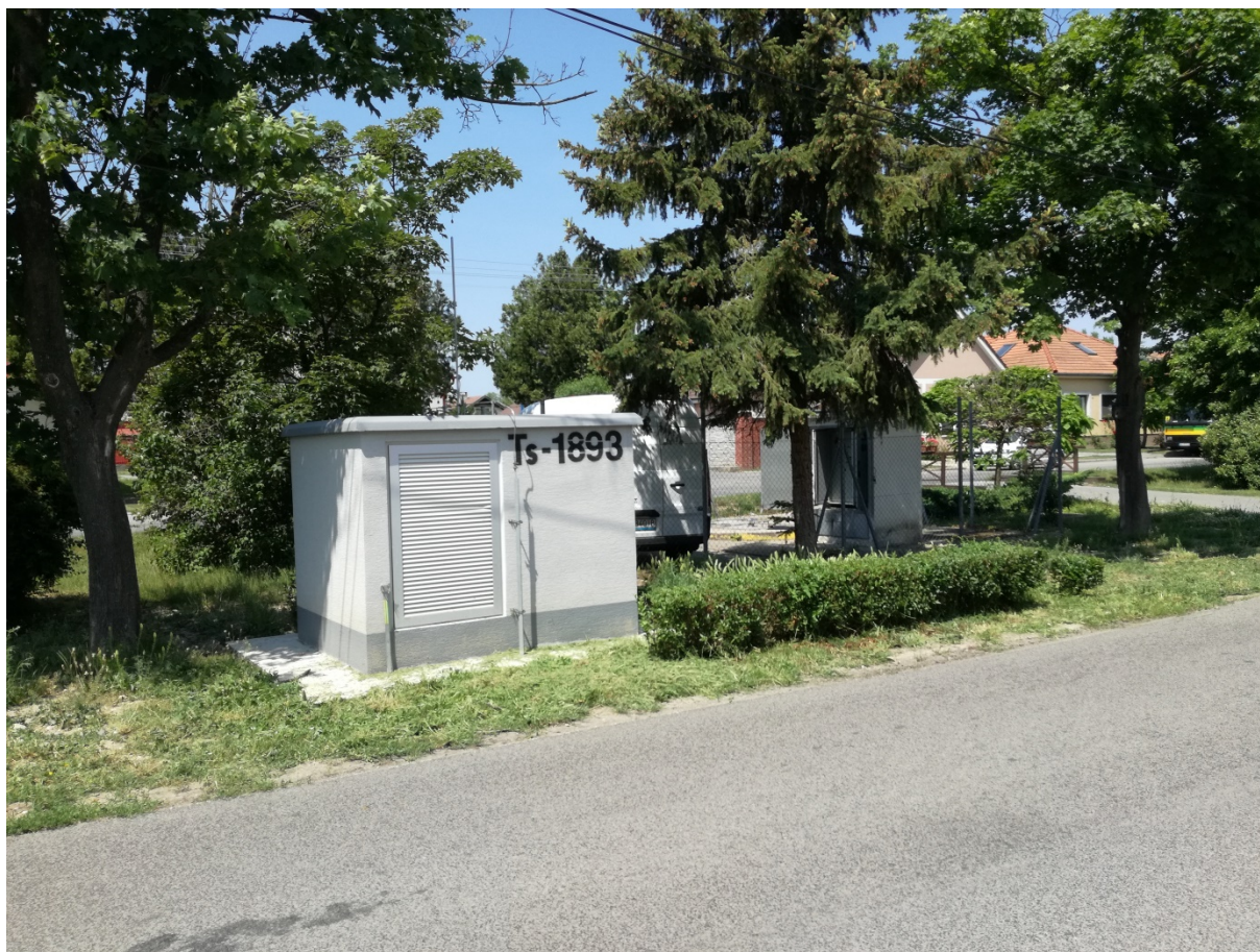
Obr. č. 1: Poloha stavby kioskovej trafostanice
