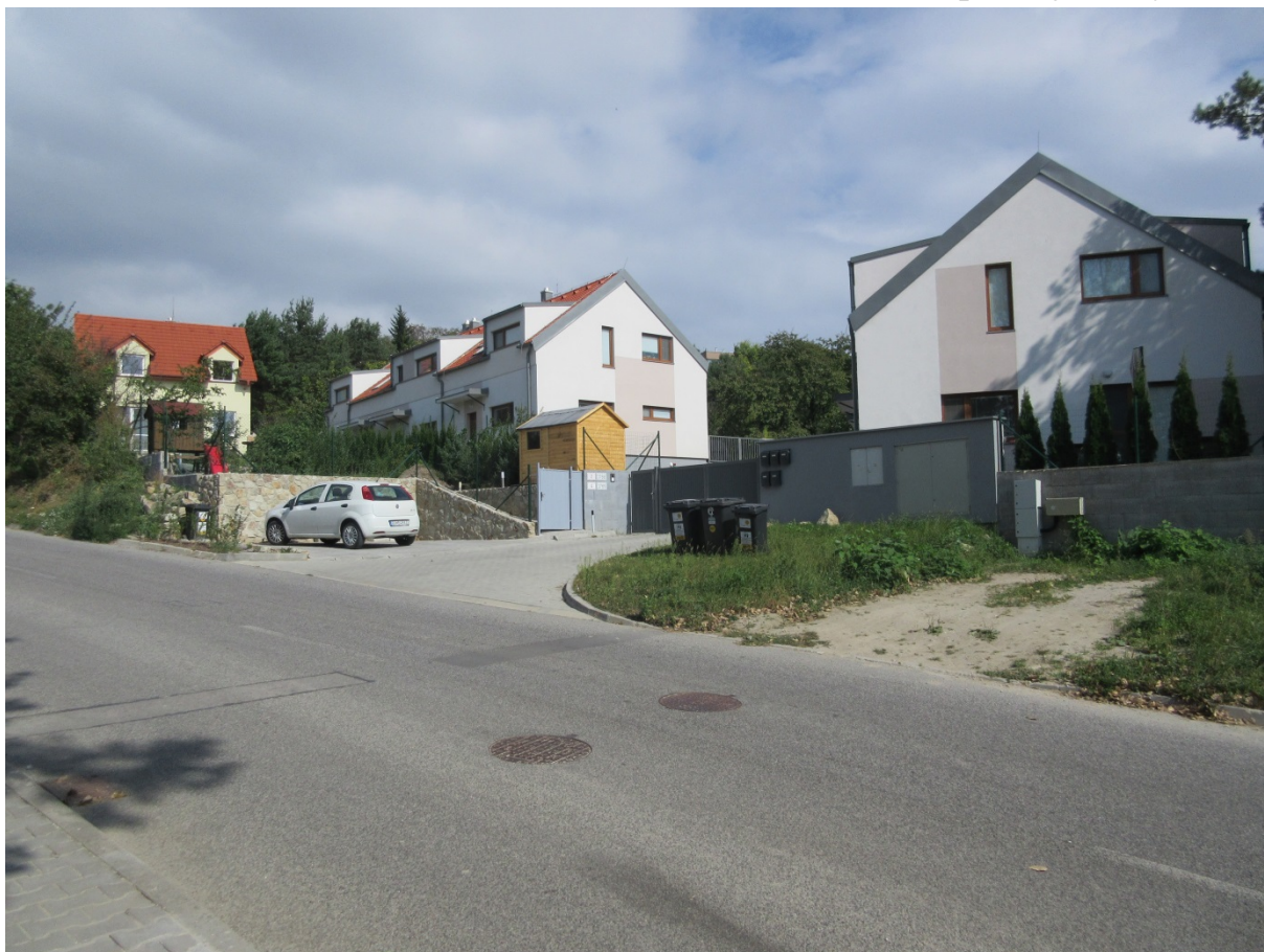
Pohľad zo spodnej strany svahu
