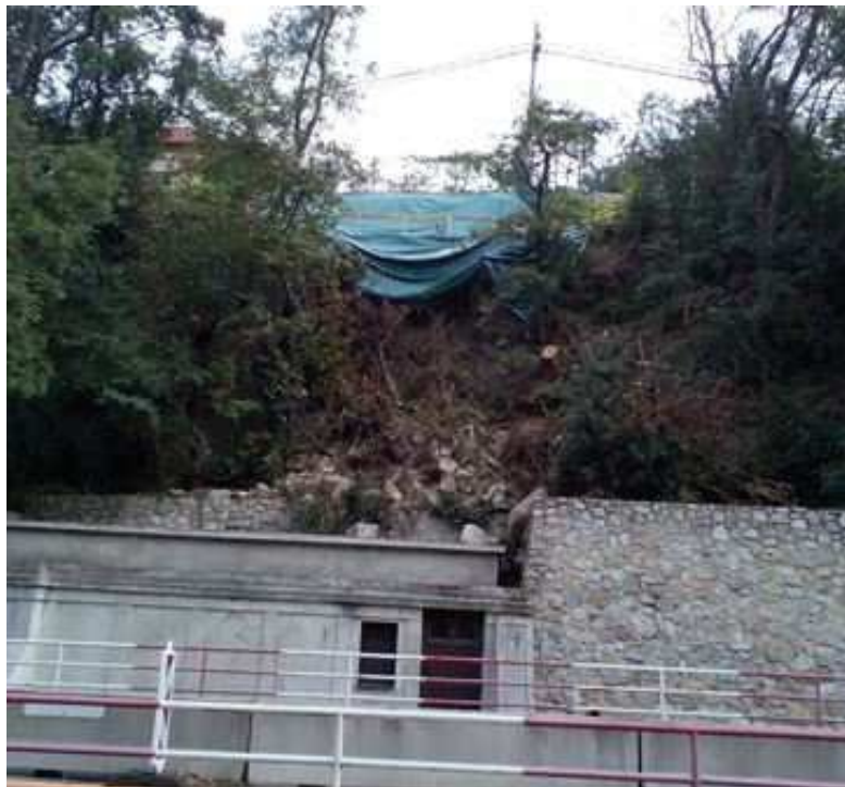
1.2. Ciele geologickej úlohy Obr.č.1.1.3. Pohľad na dočasné prekrytie ohrozeného úseku
