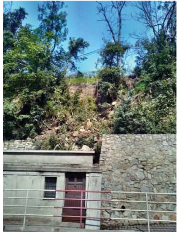
Obr.č.1.1.2. Pohľad na teleso svahovej deformácie
