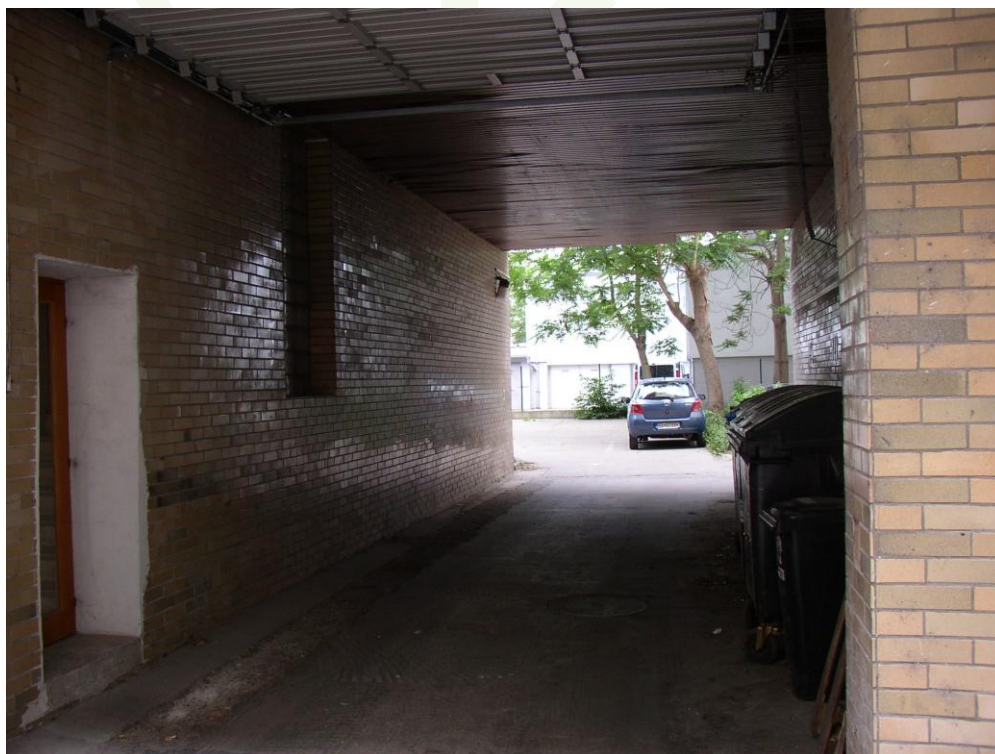
Pohľad do podjazdu z Medenej ulice smerom do dvora na parcelu č. 172/3
